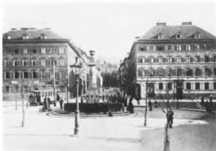
1d Wilhelmplatz (Vorkriegszustand) Angelegt 1827 als zentraler Platz zwischen der mittelalterlichen Leonhardsvorstadt und der neuen Tübinger Vorstadt, die Mittelachse fortgeführt von der kurzen Wilhelmstraße mit dem abschließenden Wilhelmstor. Der aus dem 18. Jahrhundert stammende und von Thouret mit einer Säule versehene
