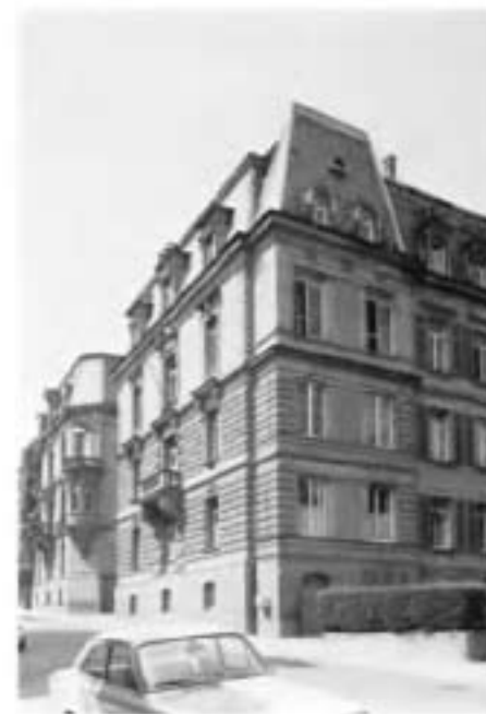
4c Villa und Miethaus in der Mörikestraße In den neunziger Jahren machte sich in der Stuttgarter Wohnhausarchitektur unter Führung von Lambert & Stahl der französische Einfluß stark bemerkbar. Ein bis heute verhältnismäßig gut erhaltenes Beispiel einer vornehmen Wohnstraße dieser Zeit und Stilrichtung stellt die Mörikestraße dar.
