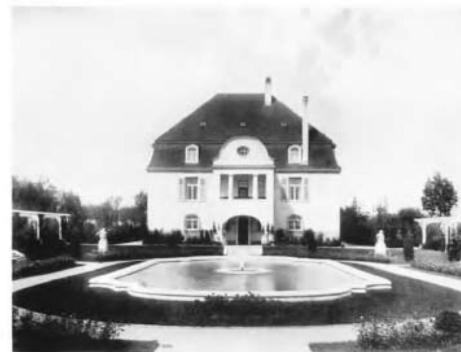
Villa des Kommerzienrats Leicht Architekten Eisenlohr & Weigle, 1906 Gartenfront
