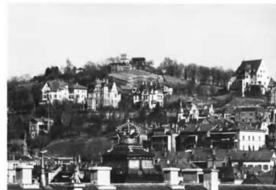
4d Villen an der Uhlandshöhe (Vorkriegszustand) Neben der in 4c gezeigten internationalen französischen Wohnhausarchitektur entwickelte sich im Villenbau der neunziger Jahre allenthalben in Europa ein nationalromantischer, heimatümelnder Stil, der sich in Stuttgart in einer Reihe von Villen auf der Uhlandshöhe manifestierte.
